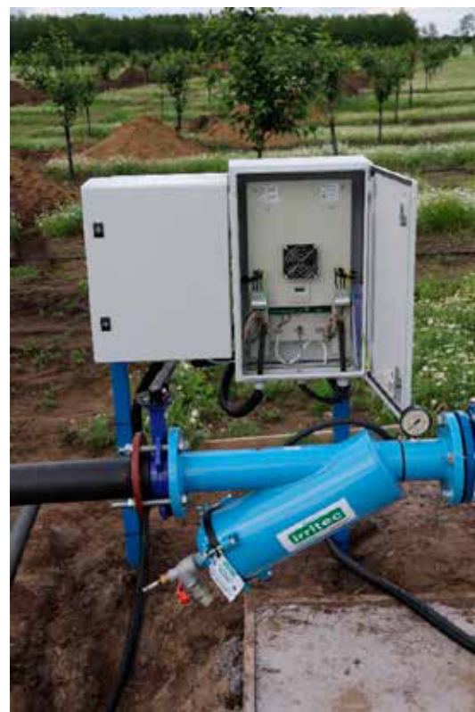
1. kép Általános célú frekvenciaváltó csőbúvár szivattyú szabályozására
